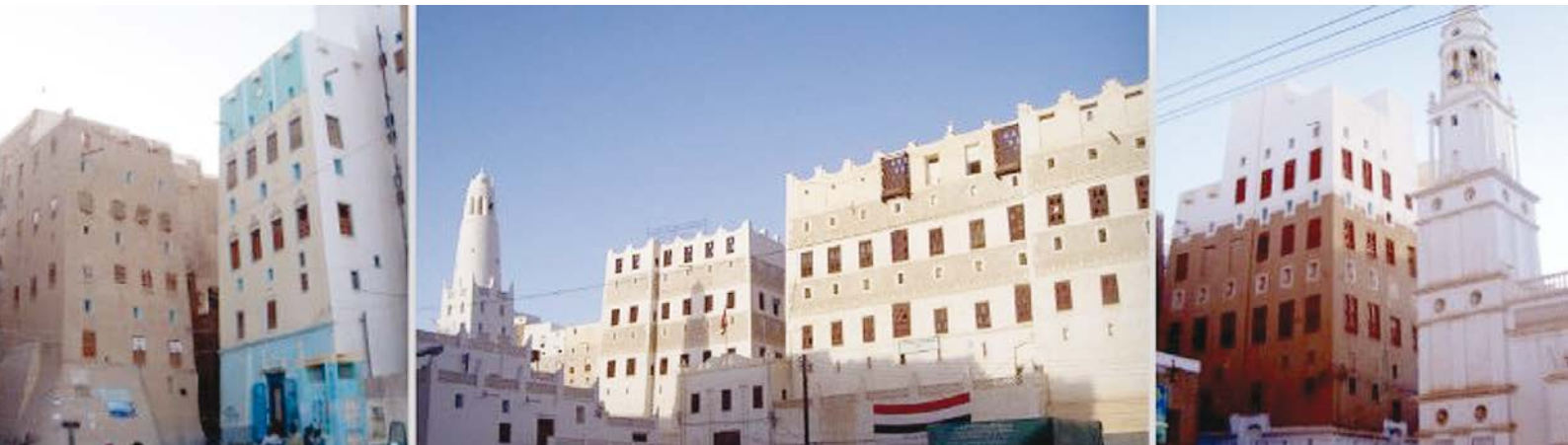
Iz glinenih opek zgrajeni visoki zgradbi – ena brez in ena z obarvano fasado (levo). Osrednji trg z mošejo Al-Jami (v sredini). Ohranjen cerkveni stolp (desno).
