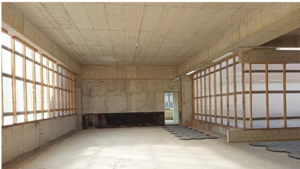
Prej – brez tlakov, napeljav, sten – goli beton (foto: lasten arhiv).
