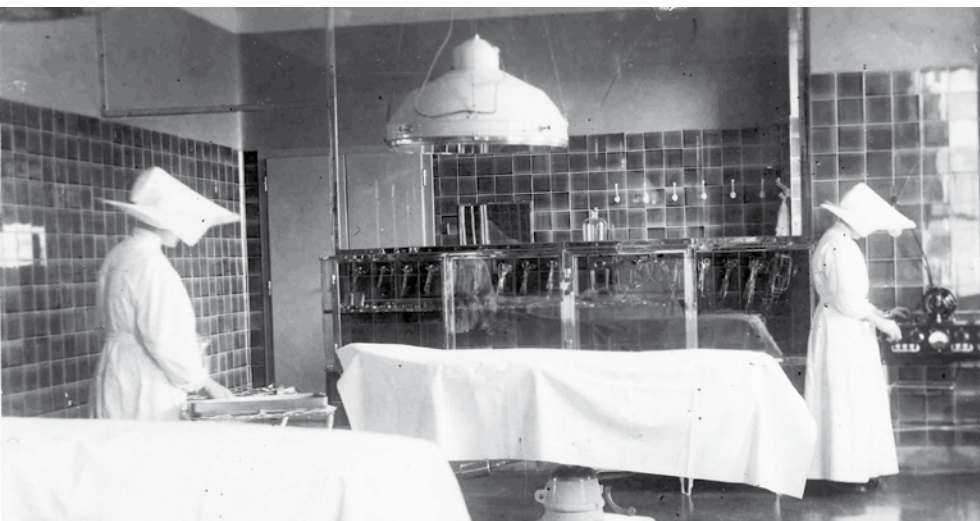
Izmed okoli 600 usmiljenk, ki so delovale v ljubljanski bolnišnici, jih je približno 50 delovalo kot instrumentarke, radiološke pomočnice, laborantke.
