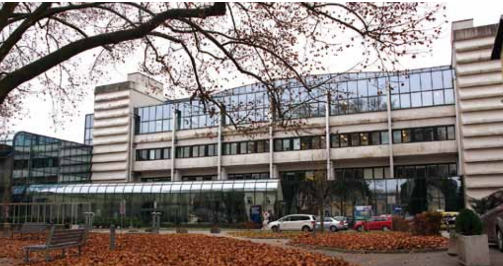
Onkološki inštitut, stavba D, E, H.
