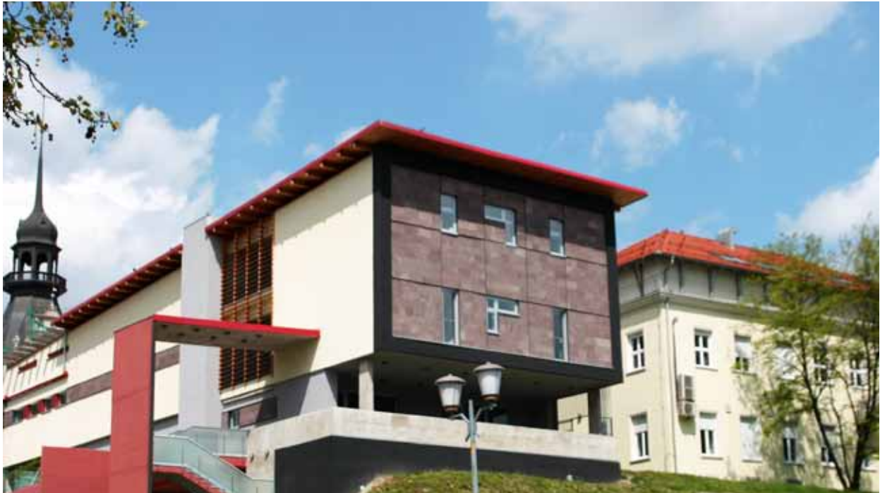
Prizidek za specialistične zobne ambulante ob nadzidani in obnovljeni zobni ambulanti v Svetozarevski ulici.
