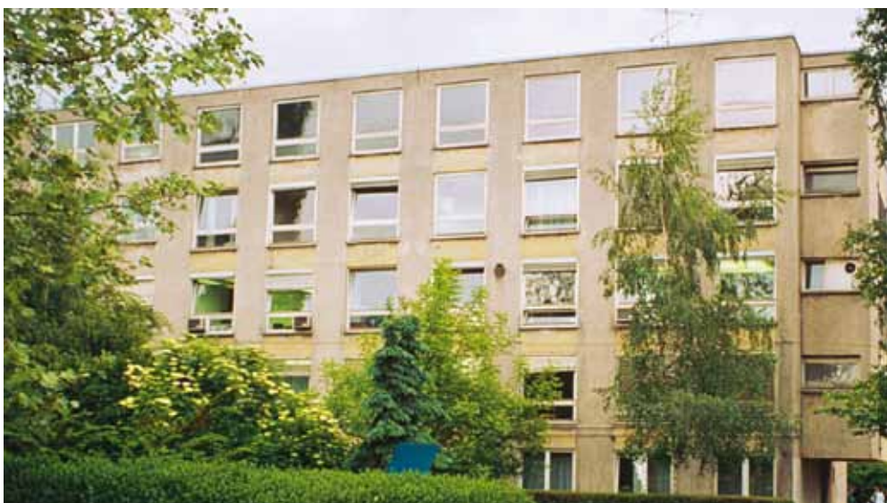
V pritličju zgradbe Višje stomatološke šole v Žitni ulici je imela svoje prostore ambulanta za ustno kirurgijo.
