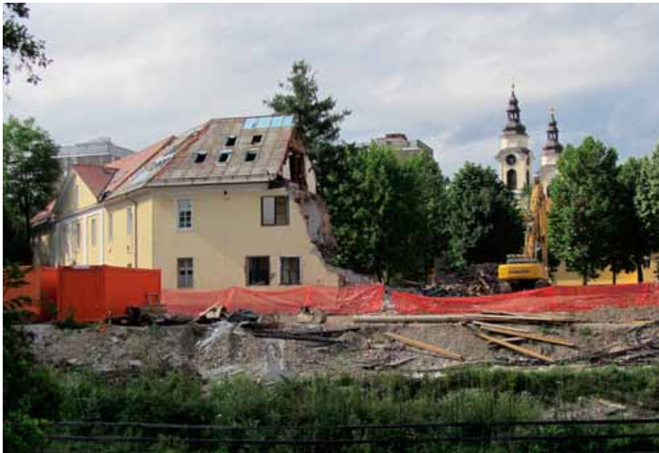
Rušenje južnega trakta šentpeterske vojašnice, kjer naj bi dobila mesto nadomestna stavba za predklinične inštitute, ki sedaj domujejo v prostorih preostalega dela rušene stavbe (foto Zvonka Zupanič Slavec, 2012).
