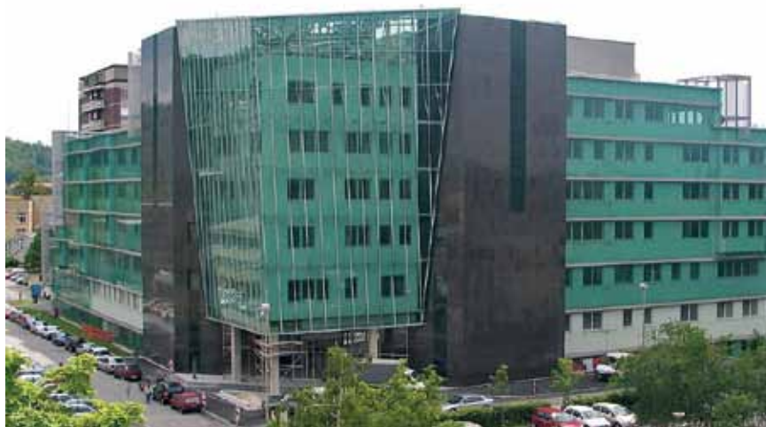
Nova stavba Pediatrične klinike v Ljubljani na Bohoričevi ulici 20, vseljena 28. junija leta 2009. Leta 1998 je bil končan medicinsko-funkcionalni program in izveden javni razpis za novo pediatrično kliniko, na katerem je bil za projektanta izbran Biro 71 z arhitektom Jurijem Princesom . Temeljni kamen za novo kliniko je bil postavljen 14. oktobra 1998. Sledile so revizije projekta in zadnja je bila dokončana leta 2003, ko so se začela tudi zemeljska dela (foto Blaž Bertonec, 2012).
