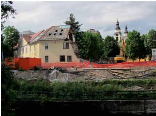
Gradnja mostu čez Ljubljanico ob Lipičevi ulici je ogrozila trdnost stare šentpeterske kasarne, ki ji zato od maja 2012 rušijo južni in vzhodni trakt. Na tem mestu naj bi našla mesto nova stavba Medicinske fakultete in v njej predklinični inštituti, ki sedaj domujejo v neustreznih prostorih (foto Zvonka Zupanič Slavec, julij 2012)
