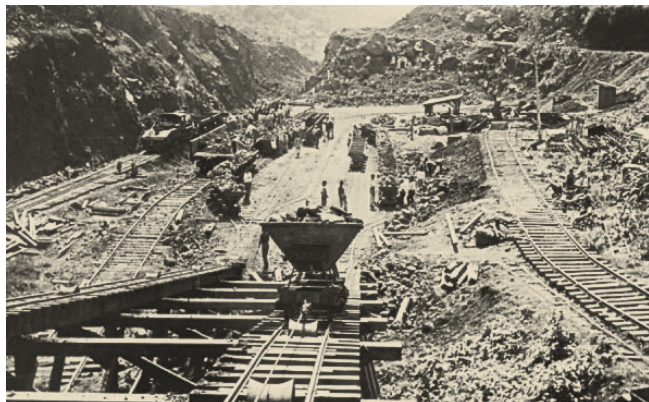
Gradnja Panamskega kanala leta 1907.
