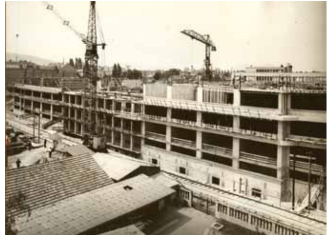
Gradnja stavbe kliničnega centra v Ljubljani l. 1967.
