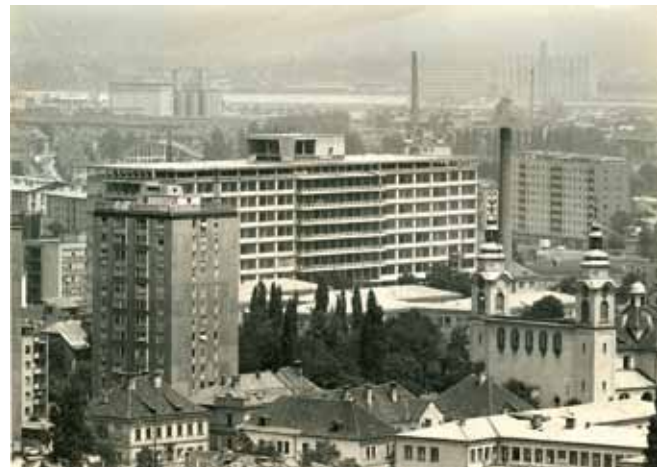
Gradnja stavbe kliničnega centra v Ljubljani l. 1968.
