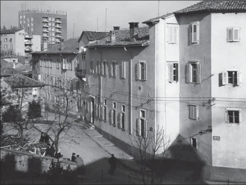
Stavba nekdanjega samostana v središču Kopra je bila dom oddelka 43 let
