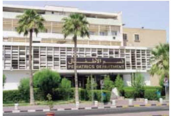
Zgradba stare otroške bolnišnice, v kateri so še vedno drugi oddelki pediatričnih specialnosti, in pročelje novega stolpča, v katerem sta otroška in razvojna nevrologija.
