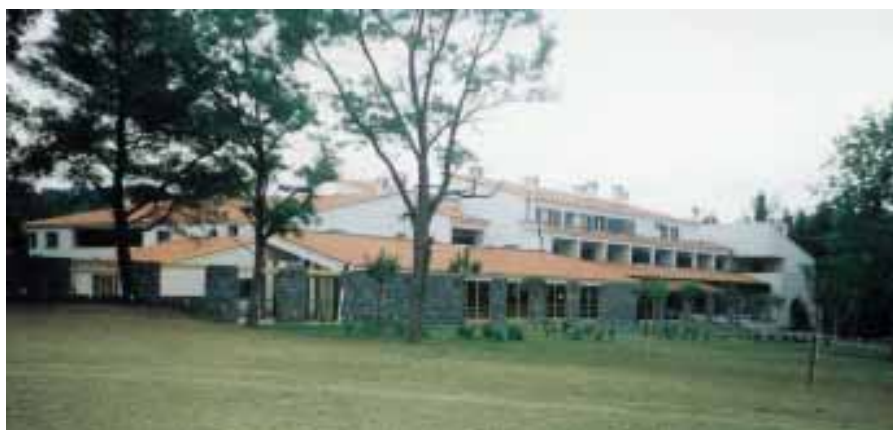
Novi paviljon po zaključeni gradnji
